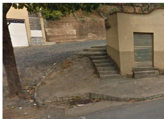
Figura 33: Identificação de casas com bocas de lobo Fonte: Conen
