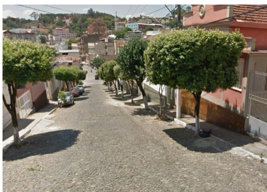
Figura 32: Tipologia das edificações e das ruas sem sarjetas e bocas de lobo Fonte: Conen
