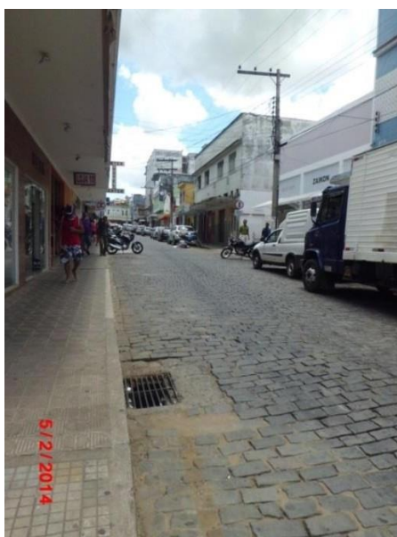
Figura 30: Boca de lobo presente no centro do Distrito Sede Fonte: Conen
