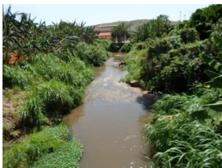
Figura 21: Ribeirão João Henrique recebe inúmeras contribuições de esgoto Fonte: Conen
