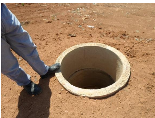
Figura 40: Poço de despejo de lixo anatômico Fonte: Conen
